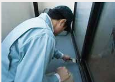
「外部(バルコニー)」調査の様子
