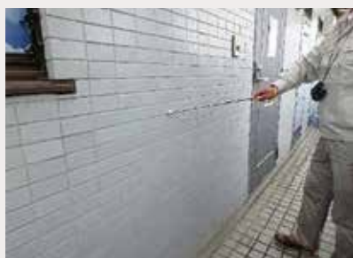
「外部(外壁)」調査の様子
