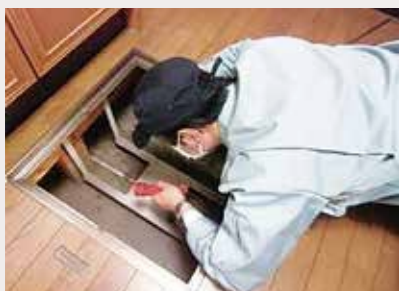
「土台・床組・基礎」調査の様子
