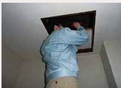
「小屋組・梁」調査の様子
